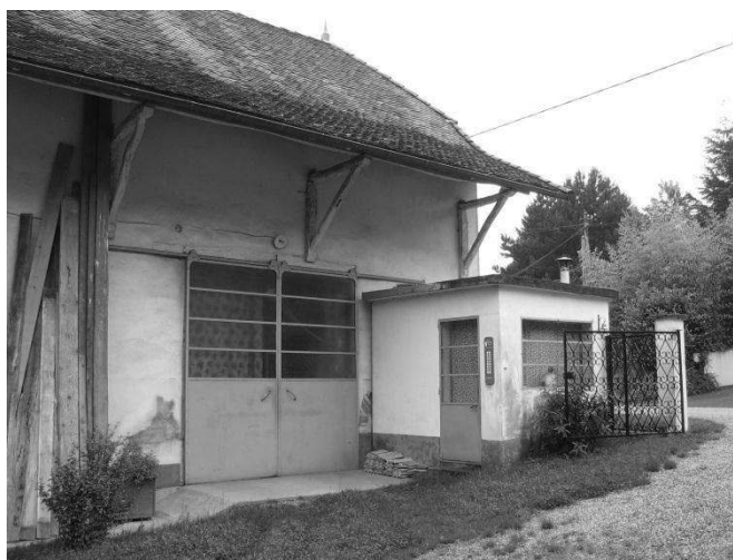
Emplacement de la cabine au garage Reynaud
